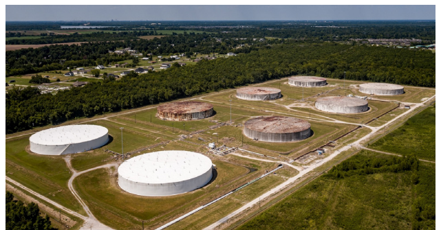
Parc de stockage d'une capacité de 2,26 millions de barils
