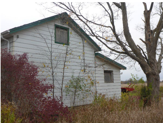
Planche 10 : Garage, façade est, vue vers le nord-ouest
