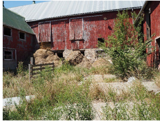
Planche 23 : Façade est de la grange centrale à toit à deux versants brisés, vue vers l'ouest
