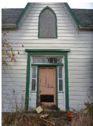
Planche 2 : Entrée avant avec imposte, fenêtres latérales et pignon central, façade avant, vue vers le nord
