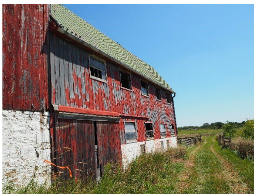
Planche 21 : Façade sud de l'annexe avec toit à deux versants brisés, vue vers le nord
