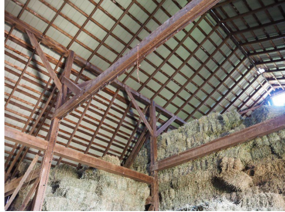
Planche 26 : Poutres, poteaux et solives découpées à la machine
