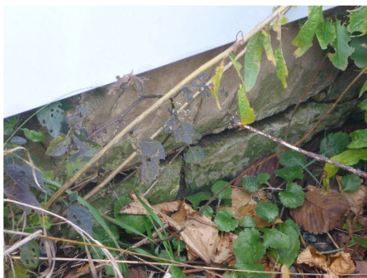
Planche 4 : Fondation en pierre taillée de la façade sud, vue vers le nord
