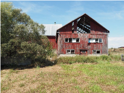
Planche 24 : Façade est de l'annexe arrière à toit à pignon, vue vers l'ouest
