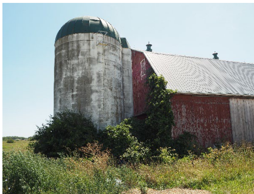
Planche 17 : Silo, vue vers le sud-est
