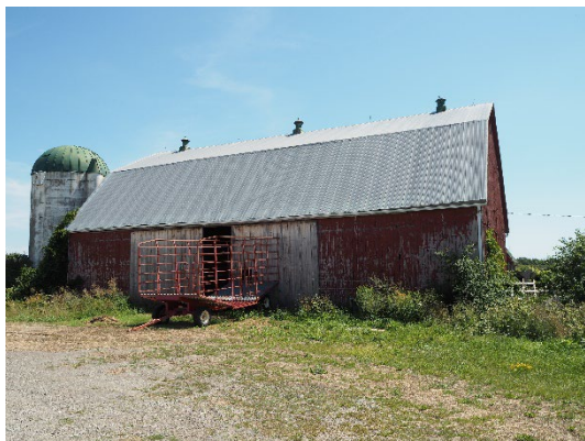
Planche 16 : Façade ouest, vue vers l'est
