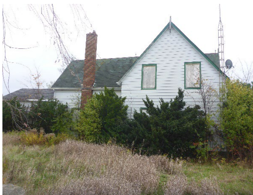
Planche 5 : Façade ouest, vue vers l'est
