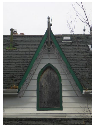
Planche 11 : Fenêtre à arc tiers-point, rive en pignon et épi de faîtage, façade est, vue vers l'ouest
