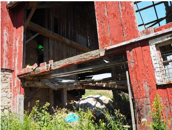
Planche 27 : Vue du toit partiellement effondré et des poutres taillées à la main
