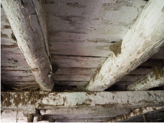
Planche 25 : Poutres taillées à la main
