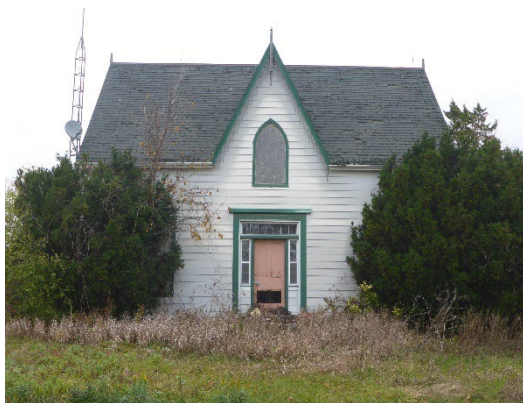
Planche 3 : Façade sud (avant), vue vers le nord
