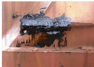
Réparations au moyen de ciment de toiture
