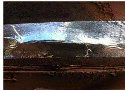
Réparations au moyen de ruban d'aluminium ou d'une bande de caoutchouc autoscellant
