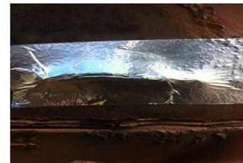
Réparations au moyen de ruban d'aluminium ou d'une bande de caoutchouc autoscellant
