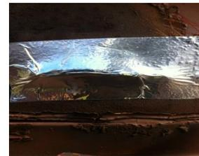
Méthode acceptée de réparation sur mur de côté
