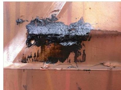
Réparations au moyen de ciment de toiture
