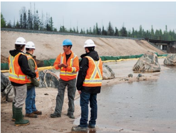
COLLABORATION À LA REMISE EN ÉTAT DE GOGAMA : Les équipes du CN et de la Première Nation de Mattagami collaborent actuellement à la phase de remise en état : ils mettent en place de la terre non contaminée et replantent des végétaux sur environ 10 acres.
