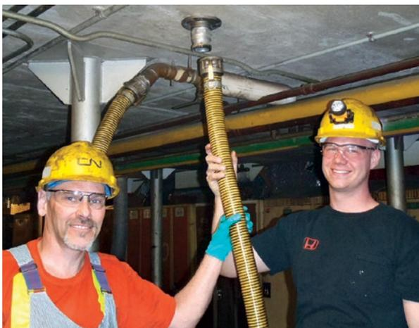
➤ **HUILE USAGÉE** : Les mécaniciens Matériel lourd Gary Cook (à gauche) et Ross Ostrander (à droite), du triage MacMillan à Toronto, vidangent régulièrement l'huile des locomotives à l'aide d'un boyau raccordé au système d'évacuation. En 2012, nous avons récupéré quatre millions de litres d'huile à des fins de recyclage.
