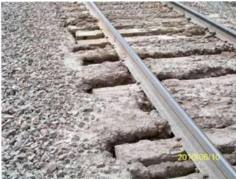
(Figure 13 : Ballast colmaté par la boue)
