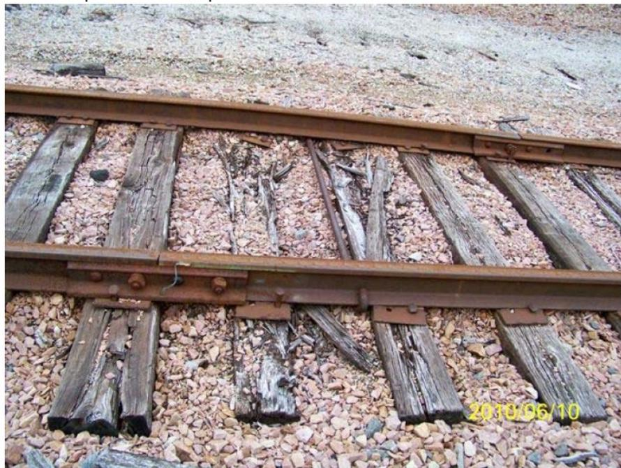
(Figure 17 : Traverse détériorée)
