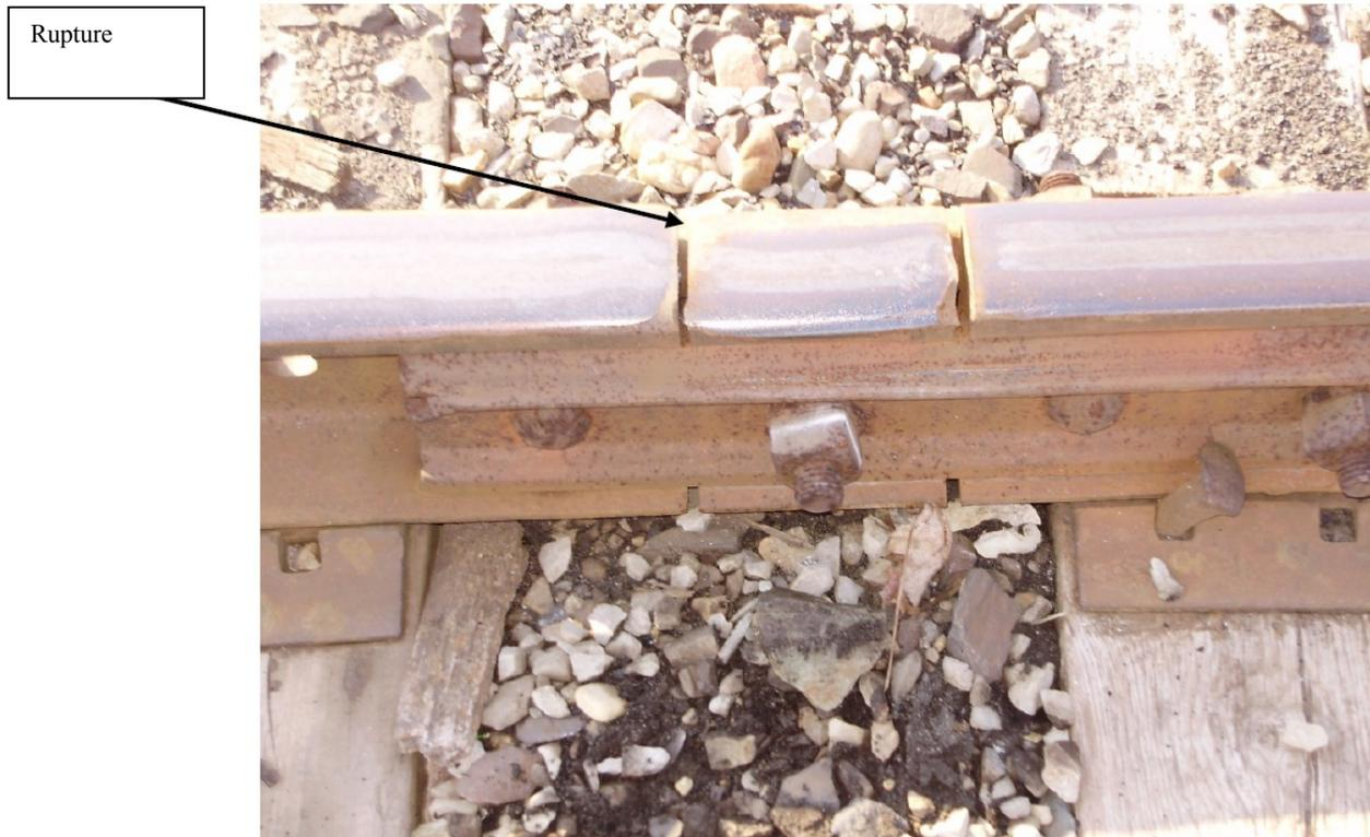
(Figure 19 : Rupture de rail)
