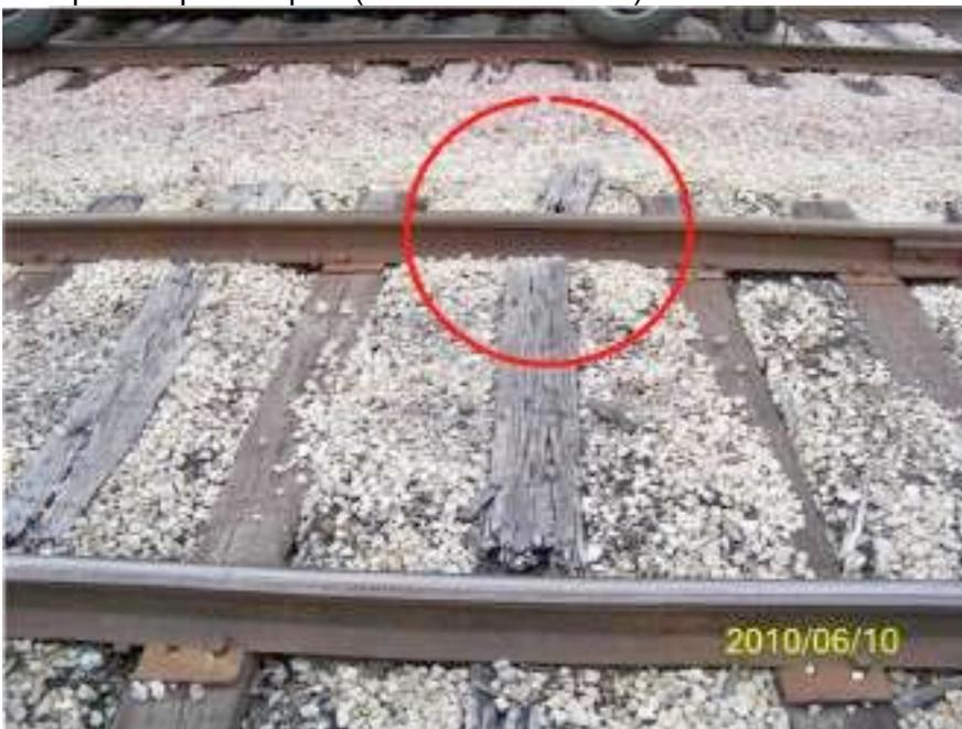
(Figure 15 : Traverse rompue)
