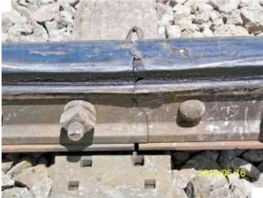
(Figure 20 : Éclisse fissurée)
