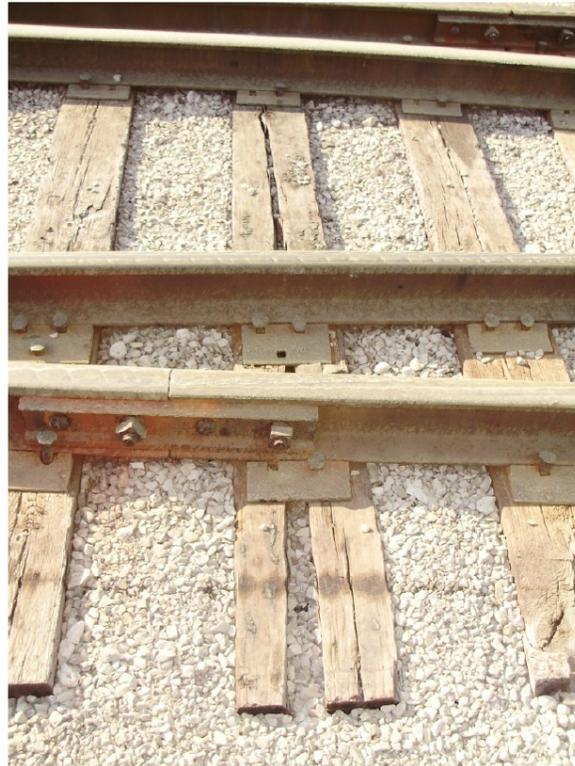
(Figure 16 : Traverse fissurée)
