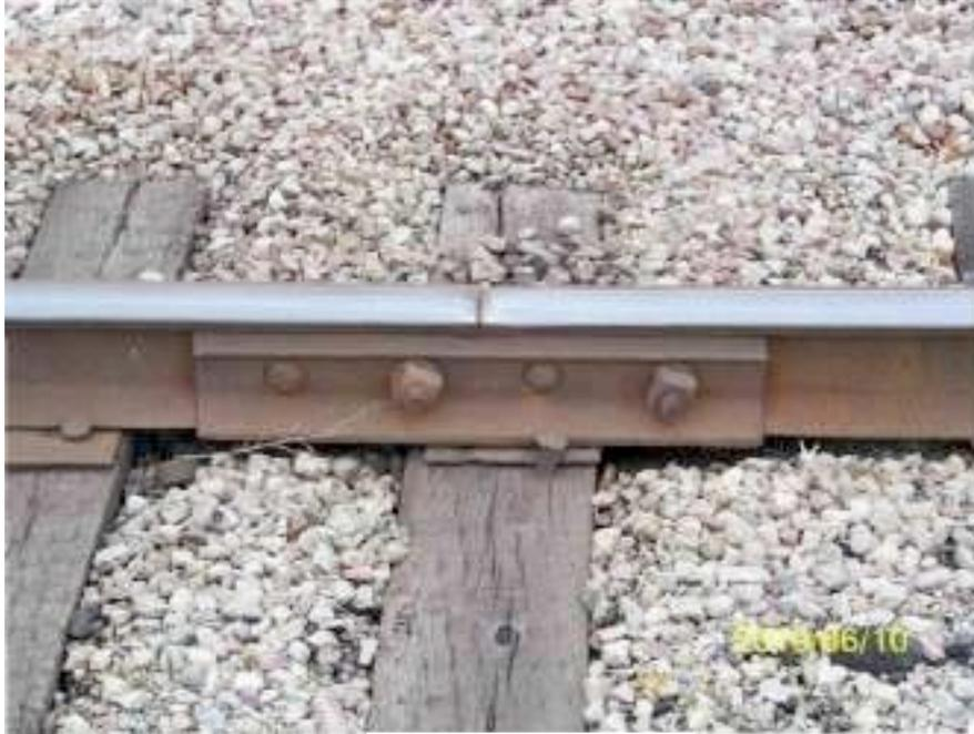
(Figure 14 : Traverse de joint)
