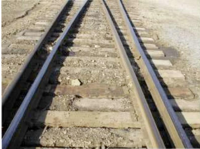
(Figure 12 : Ballast colmaté par la boue)
