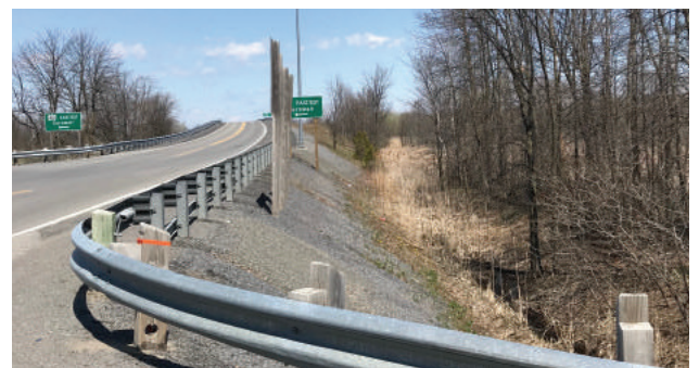
Vue vers le nord à l'intersection de l'autoroute 401 (sortie 778); le site est à droite
