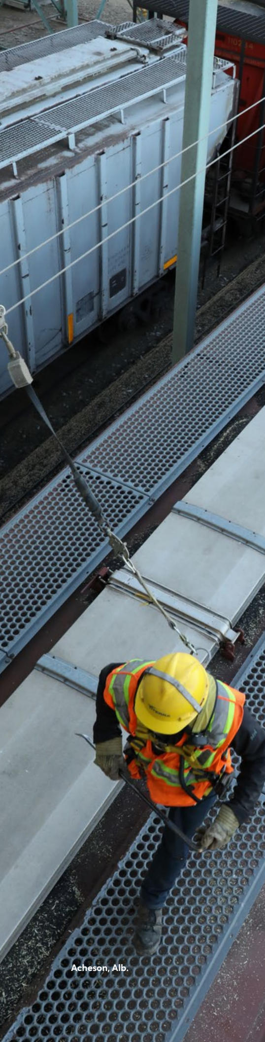
Figure 1. Protection contre les chutes – Dispositif échelle-plateforme
